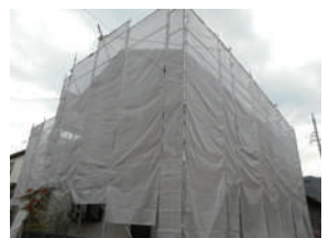
足場のメッシュシート
