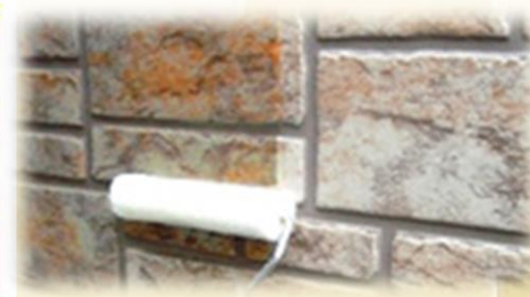
「キクスイSPフッ素クリヤー」施工状況
