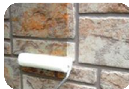
2液水系ふっ素樹脂クリヤー 「水系スーパーUVコートクリヤーF」
